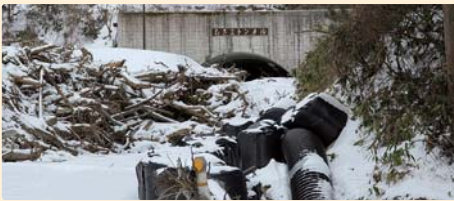
▶ 現在も通行止めのトンネル
